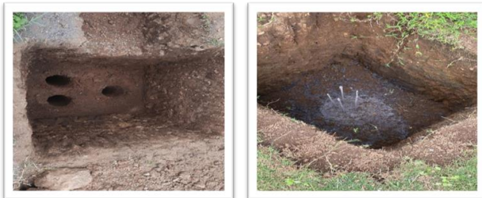
Gambar 2. Proses Penggalian Tanah Dan Pengecoran Wahana Swing
