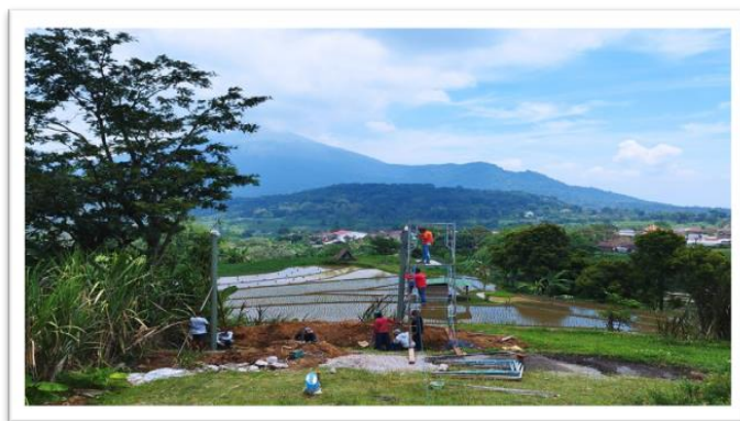
Gambar 4. Pemasangan Tali Wahana Swing
