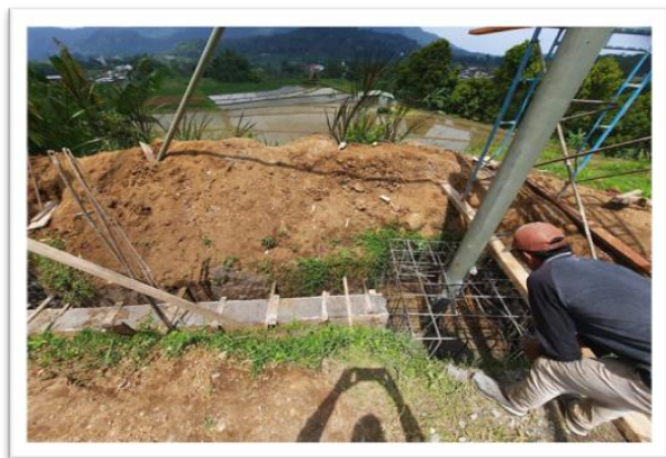
Gambar 3. Pemasangan Besi
