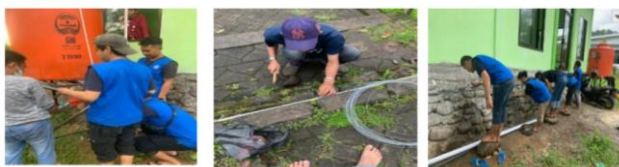
Gambar 2. Pembangunan Instalasi Air Bersih
